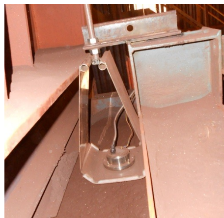
Figura 7 - Instalação do sensor para medição de umidade.
