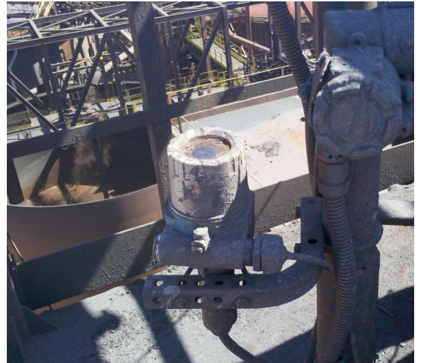
Figura 10 - Condição da eletrônica do transmissor na área.
